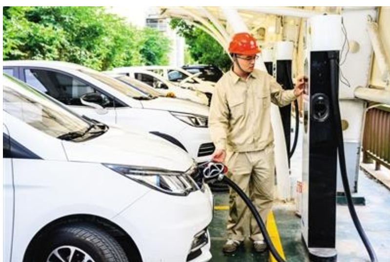
无锡一处室外充电站，供电公司员工正帮忙给电动汽车充电。资料照片
